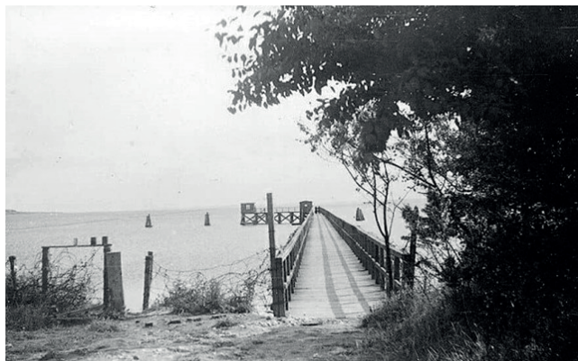
Alle slags tyske fartøjer lagde til ved den lange anløbsbro, der dog først og fremmest var beregnet til ubåde. Broen gik over 200 meter fra stranden, for ubådene kunne kun lægge til på dybt vand.
